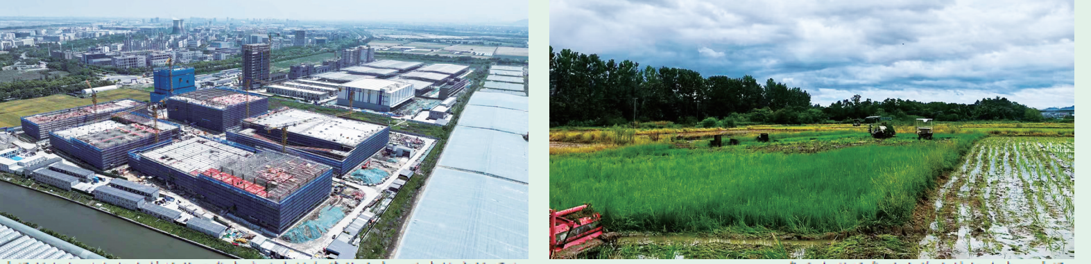
建设银行绍兴分行支持的长三角农产品冷链智慧物流中心及农批市场项目。
