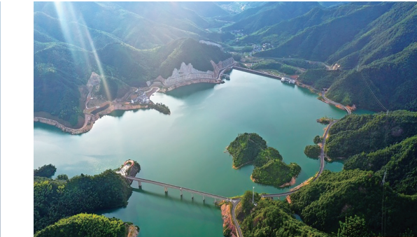
衢州龙游高坪桥水库
