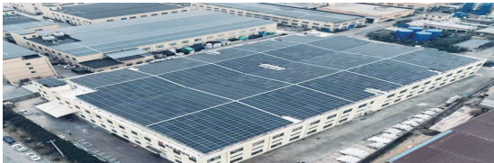
恒信农商银行绿能贷光伏项目落地投产。
