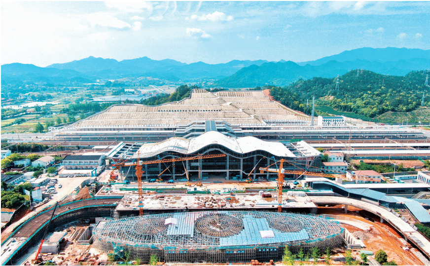
杭衢高铁项目江山高铁站施工现场。吴晴明 摄
