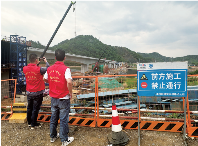
人保财险衢州常山支公司工作人员在常山江航电枢纽工地查看建设安全情况。邱慧杰 摄
