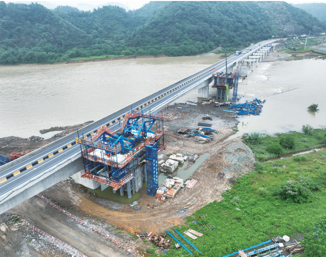
常山江航电枢纽富山村长圩大桥施工现场。姜剑涛 摄
