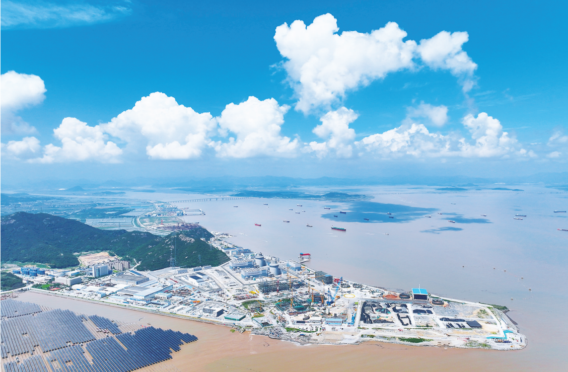
图为三门核电工程项目。
