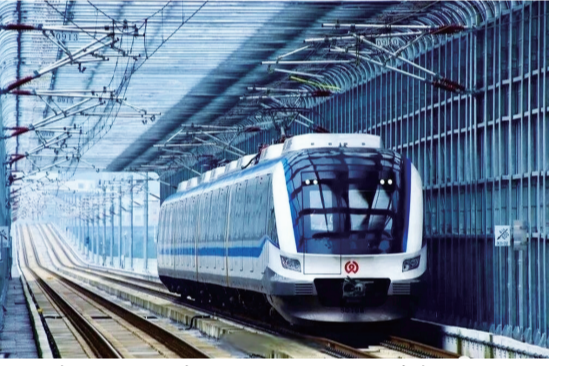
建设银行支持的绍兴地铁1号线带来低碳、便捷的出行体验。
