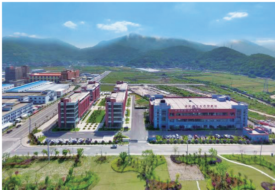
普陀海洋生态创新谷污水收集和预处理工程实景
