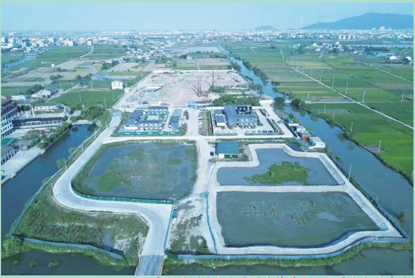
中行温州市分行贷款支持苍南江南再生水厂建设
