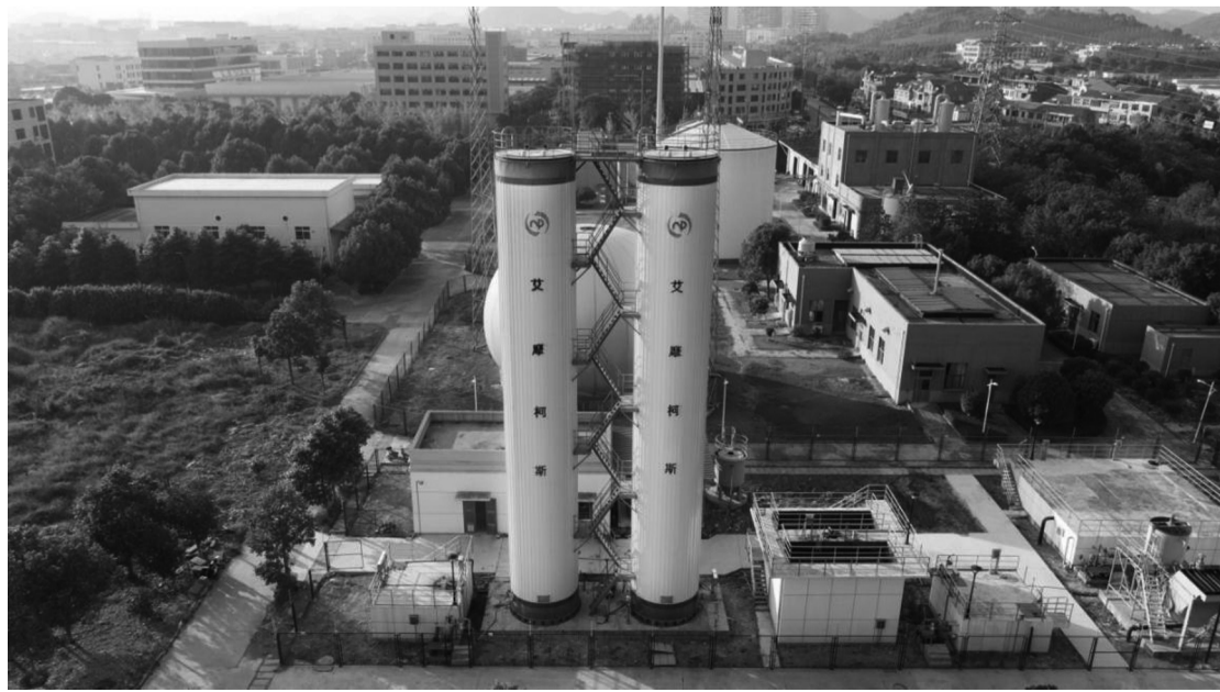
艾摩柯斯市政污泥水处理站全景
