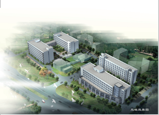
建设中的科研综合楼
