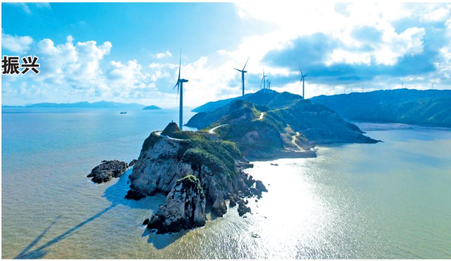
近日,玉环市大麦屿街道鹭鹭礁风力电场在蓝天白云的映衬下,壮美如画。该电厂装机容量49.5兆瓦,设置风力发电机组25台,年发电量达1.2亿度,成为玉环迄今为止单体投资最大的一个海洋新能源清洁生态项目。
