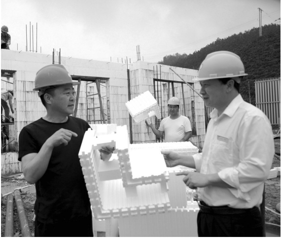
图为公司人员在介绍EPS模块施工
