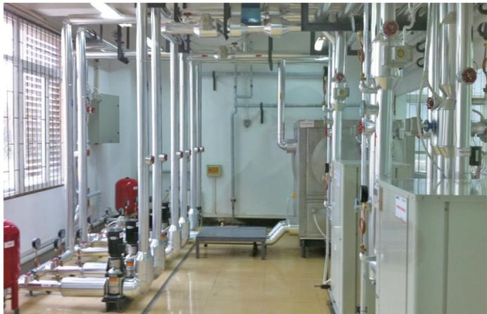
石磊介绍说:“地源热泵中央空调系统是一种利用浅层地热资源,既可采暖供热水又可制冷的空调系统,具有传统空调和热水系统无法比拟的节能、高效、环保等优点。”目前,地源热泵空调系统主要应用于车站、学校、
