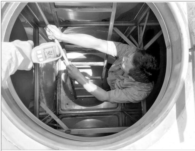
为保证高峰供水期间山区饮用水水质安全,绍兴柯桥供水有限公司近期组织精干力量,对全区15个山区泵站箱式无负压设备的蓄能水箱进行冲洗和消毒,并对冲洗后的水质进行检测,确保各项指标均符合国家生活饮用水卫生标准。图为工作人员正在作业。
